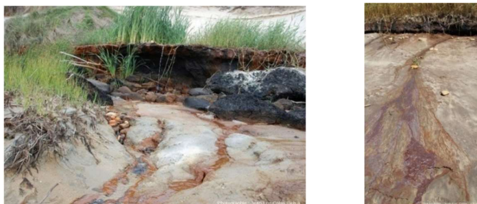
Coulées d'eau ferrugineuse © J-L. Colas / v.h.a.
