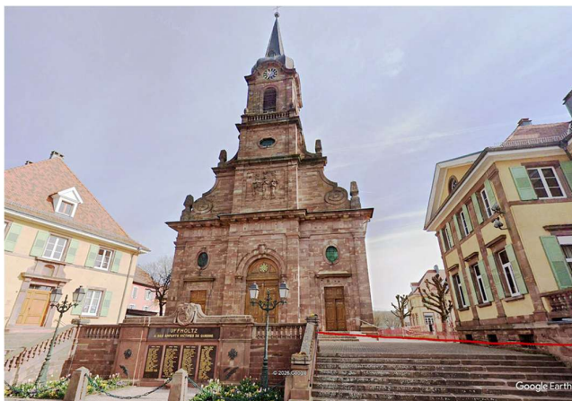
Église d’Uffholtz construite en grès des Vosges (grès rose)
