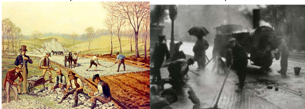
Empierrement d'une route selon la technique Macadam en 1823. Au premier plan concassage de pierres pour obtenir la granulométrie requise © Carl Rakeman, dom public
