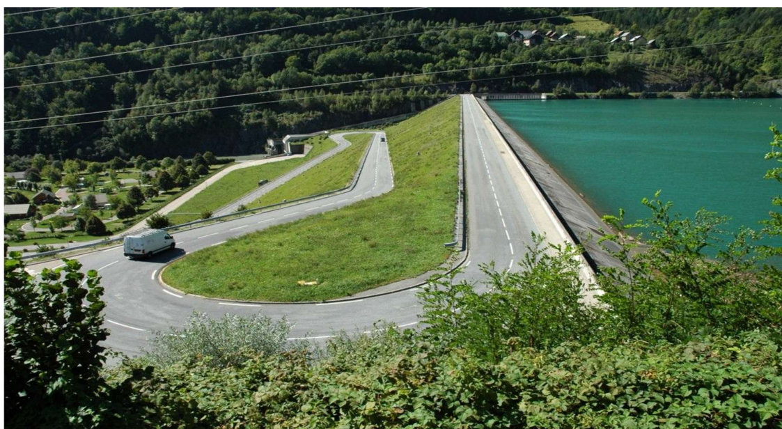
Barrage du Verney © A. Mortini Lat. : 45° 7'44.86"N , long. : 6° 2'37.10"E
