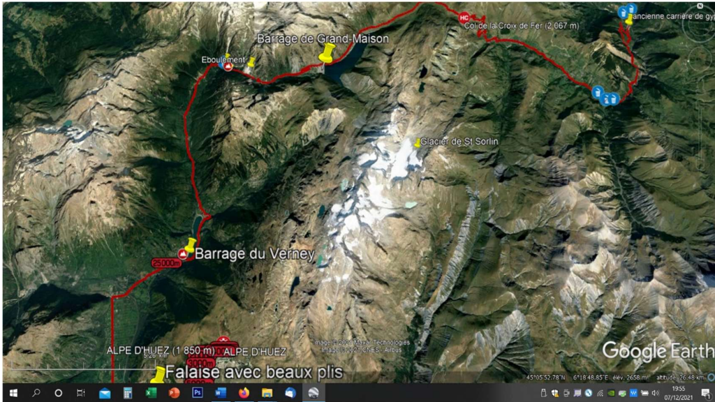
Barrage de Grand-Maison Lat. : 45°12'20.82"N, long. : 6° 6'57.38"E
