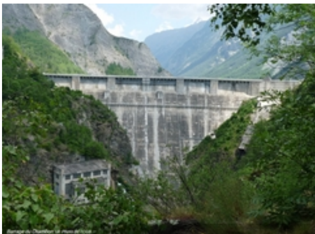
Le barrage voûte du Chambon
