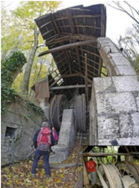
Restes d'installations de surface
