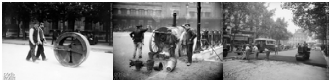
Passage d'un rouleau pour le lissage de l'asphalte © J. Boyer/ Roger Viollet 1908 // Voiture chauffante pour le bitume © J. Boyer/ Roger Viollet 1908 // Épandage de bitume, XX e siècle, © BHVP/RogetViollet
