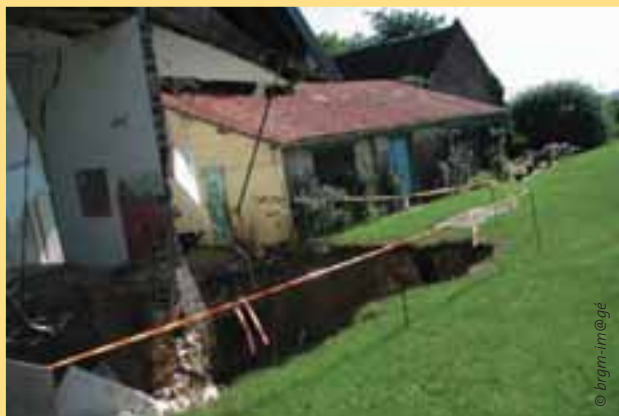
Effondrement de terrain en zone urbaine.
